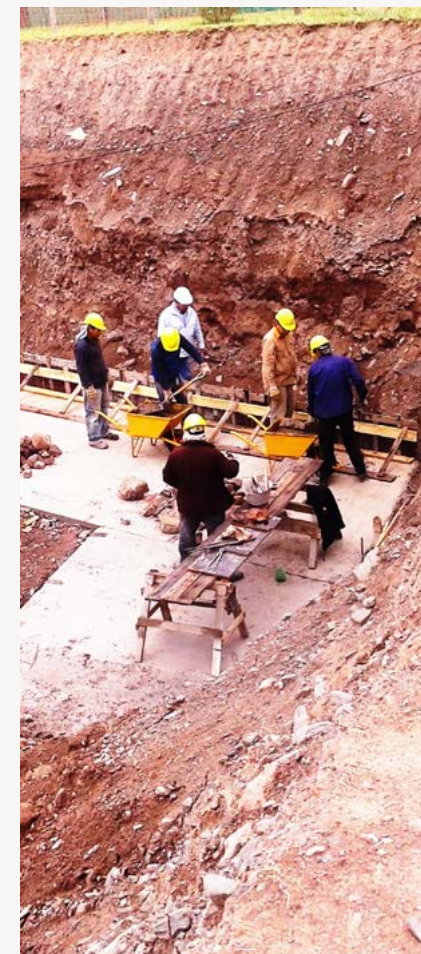
Construcción del nuevo edificio, febrero 2016.
